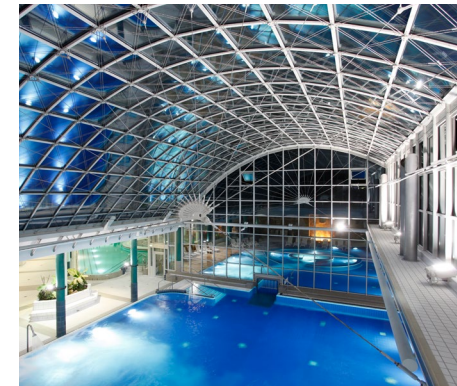
Dafür, dass die Technik in den Bädern funktioniert, sorgt der Elektroniker für Betriebstechnik.
